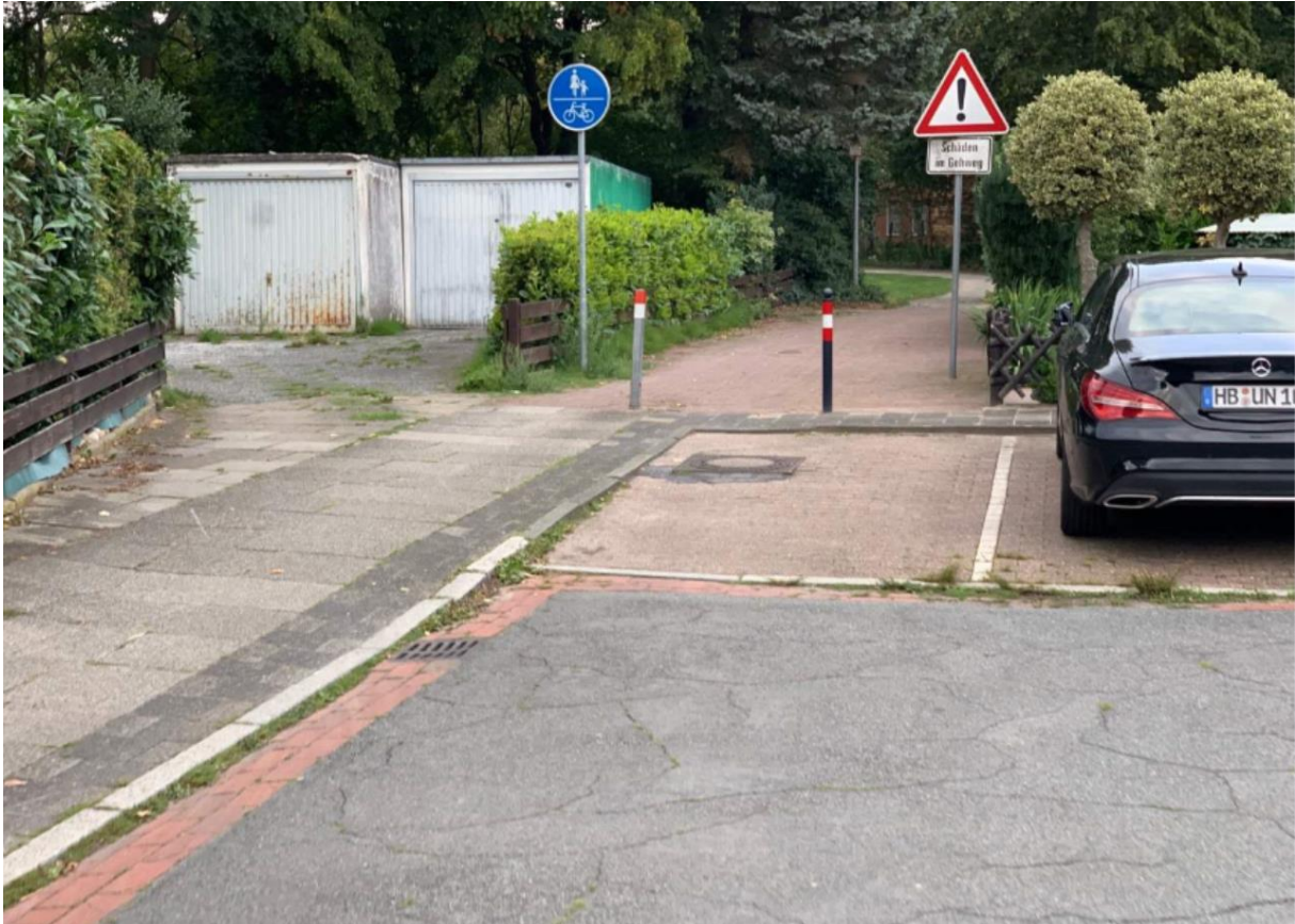
Geh- und Radweges in Verlängerung der Traberstraße Der Fuß- und Radweg endet in einem Stellplatz und ist nicht abgesenkt
