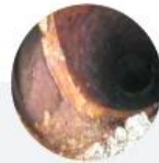
Verschobene Verbindung
