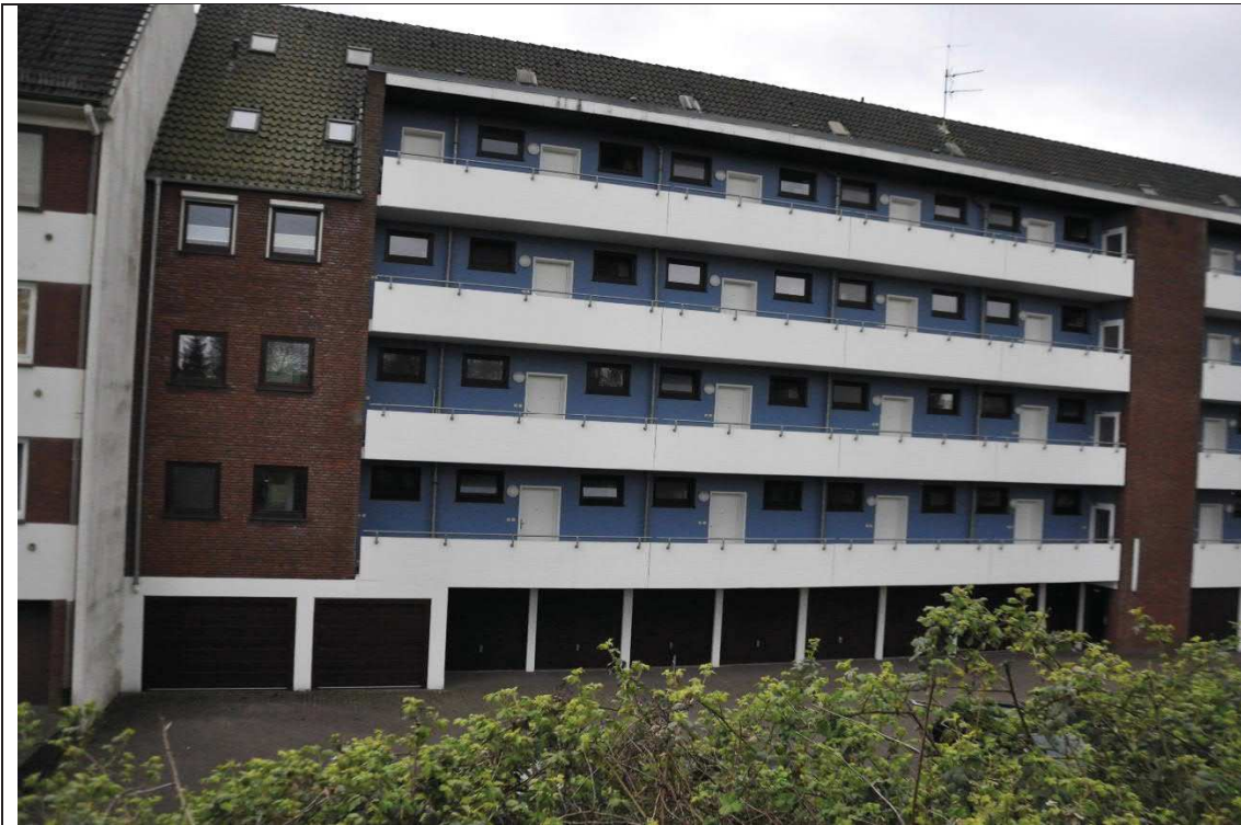
Abbildung 8: Stolzenauer Straße 18, Erdgeschoss mit Garagen
