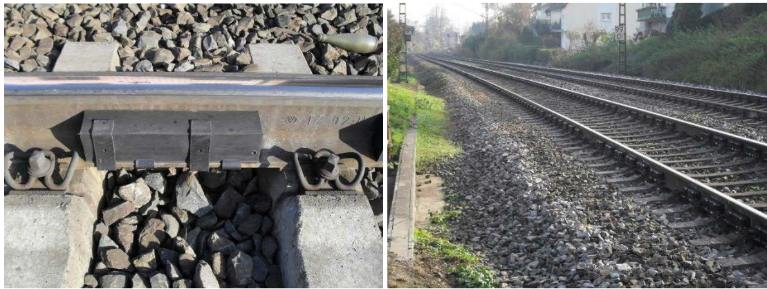
Abbildung 3: Schienenstegdämpfer
