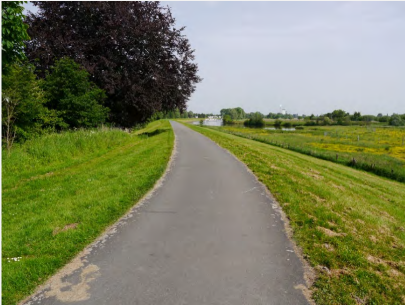
Deich Arsten mit Radfernweg
